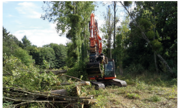
Travaux d'abattage des peupliers ↓
