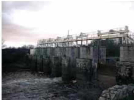
Photo 5 - Écluse du canal de Buzay (vue aval).
