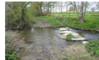
Photo 17 - L'Ognon, tronçon 3 : passage à gué.
