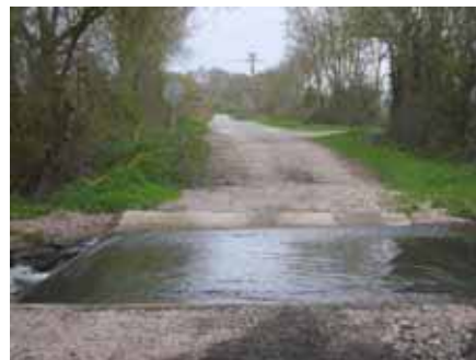
Photo 4 - Exemple de franchissement terrestre : les passages à gué.
