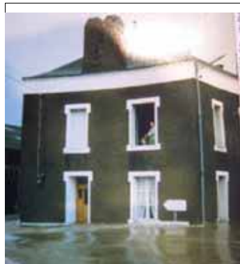
Illustration 10 - L'Ognon à Montbert, crue du 7 juillet 1977.
