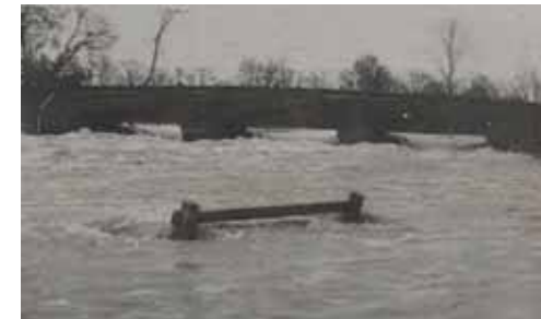
Illustration 11 - Le pont de la Boulogne, à Saint-Philbert-de-Grandlieu, 11 avril 1983 - Courrier de l'Ouest .
