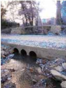
Photo 1 - Exemple de franchissement terrestre : les passages busés.
