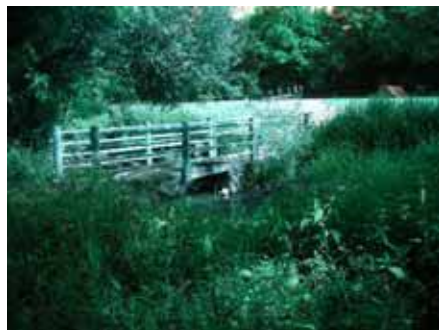
Photo 3 - Exemple de franchissement terrestre : les passerelles.
