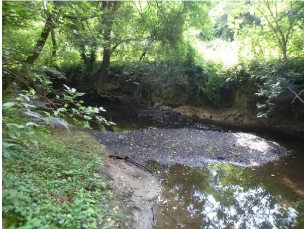
Radier avec atterrissement
